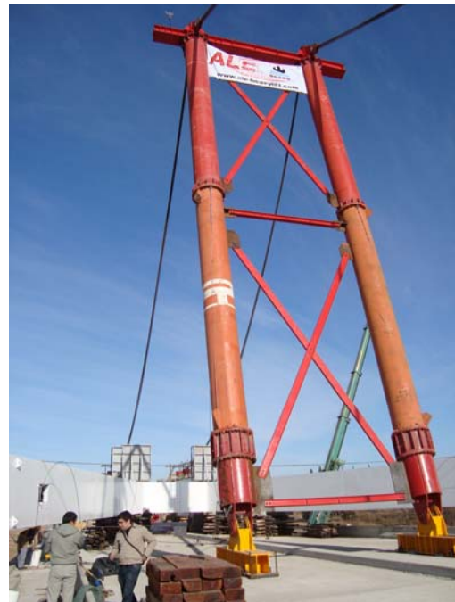
Figura 3. Pórtico de volteo
