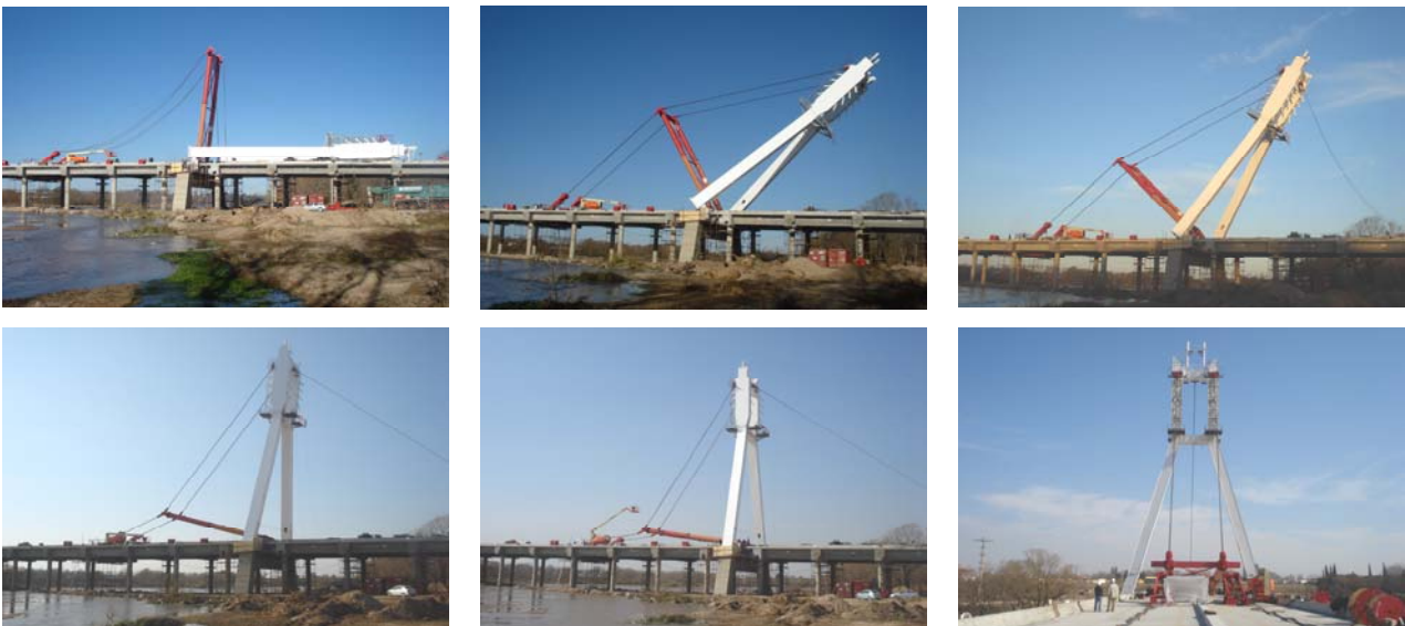
Figura 2b. Secuencia completa del rebatimiento de la Pila N° 5
