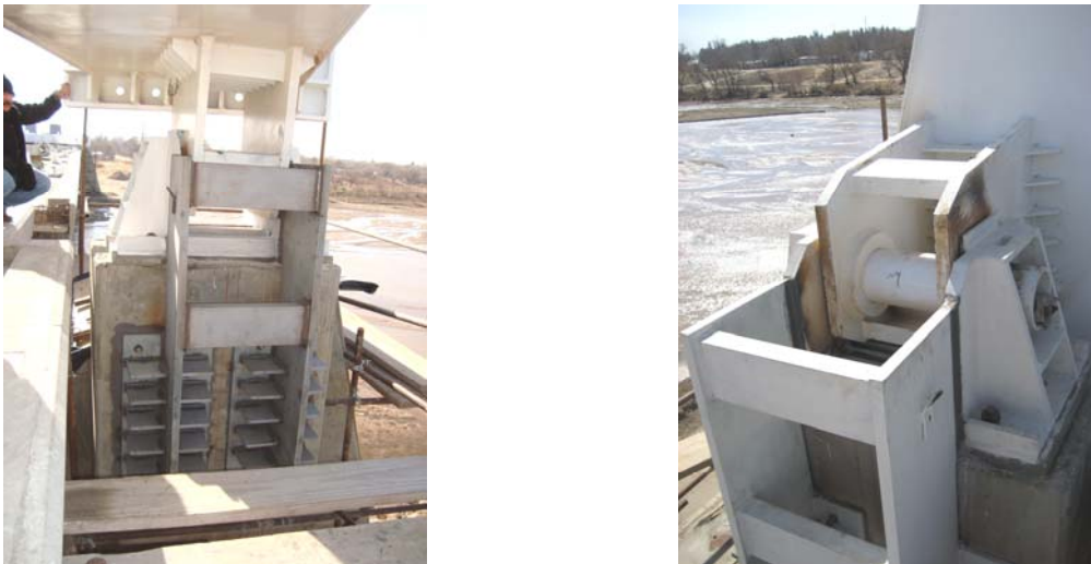
Figura 5. Bisagra de giro
