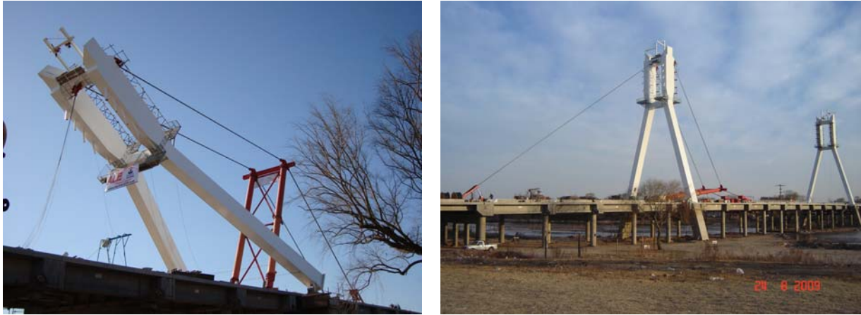
Figura 1a. Vista general del rebatimiento de la Pila N° 5
