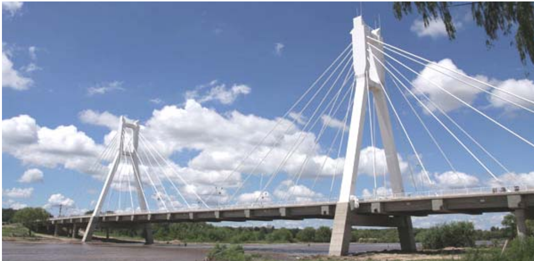
Figura 1. Vista general del Puente Atirantado sobre el Río Cuarto
