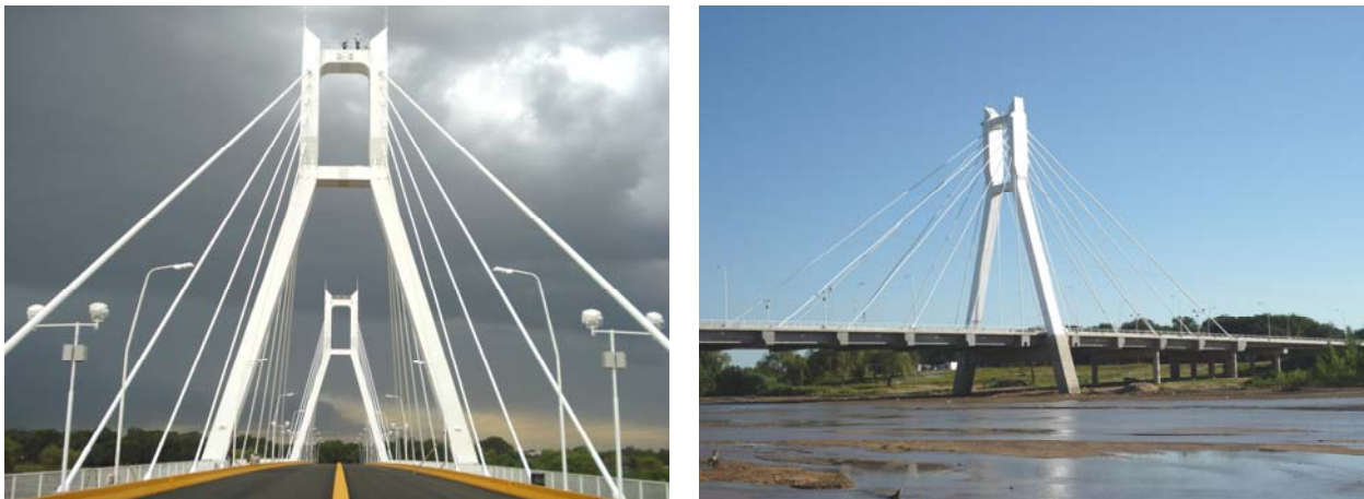
Figura 2. Vista general del Puente Atirantado sobre el Río Cuarto
