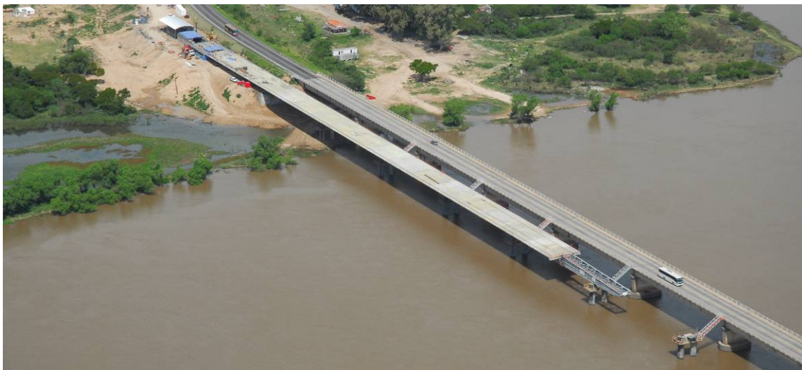
Figura 16. Vista general de la playa de prefabricación, tren de dovelas y nariz de lanzamiento metálica
