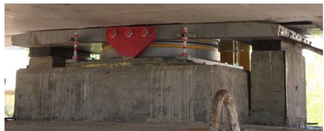
Figura 14. Apoyo tipo POT con deslizador superior
