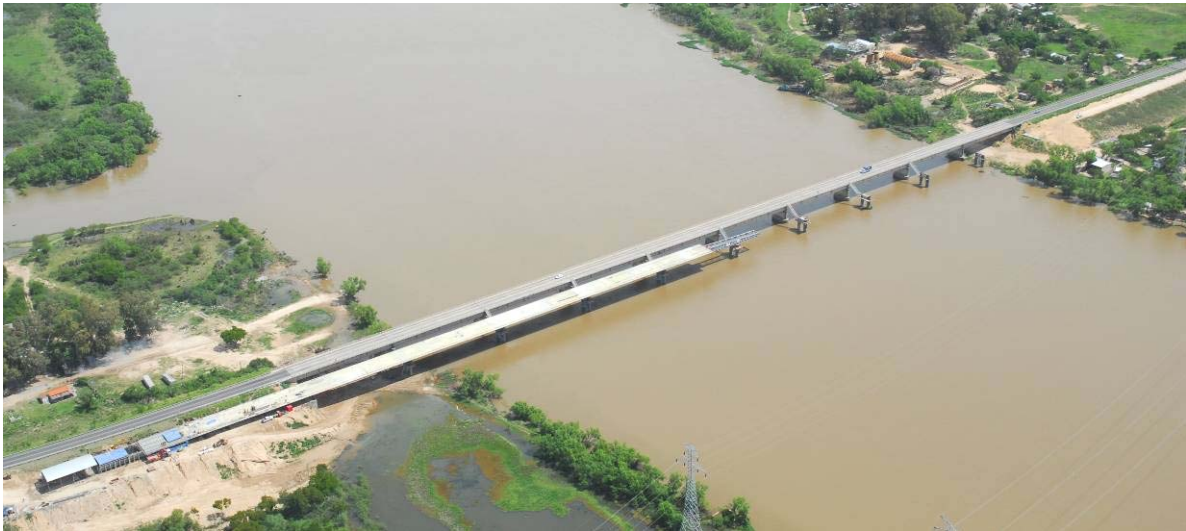
Figura 1. Vista general del Puente Lanzado sobre el Río Colastiné
