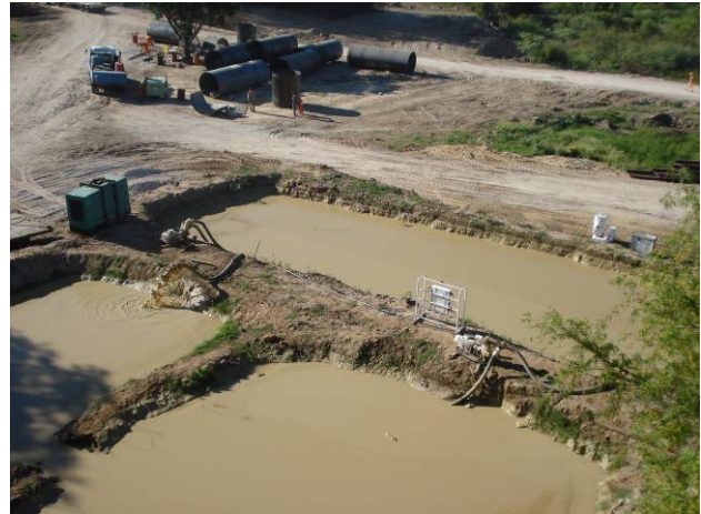
Figura 9b. Excavación de perforación sobre barcaza
