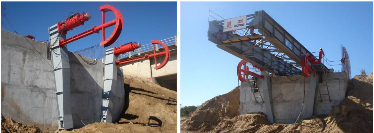
Figura 2. Vista general del Estribo Lado Paraná
