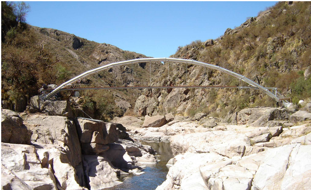
Figura 1. Pasarela Peatonal Quebrada Condorito
