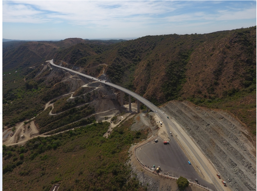
Figura 1. Vista general de los Viaductos 1, 2 y 3
