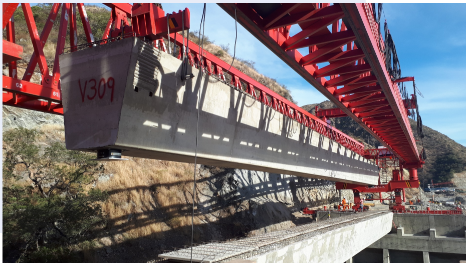
Figura 4. Construcción mediante viga de lanzamiento metálica
