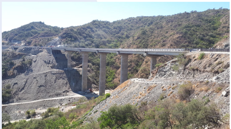
Figura 2. Vista particular del Viaducto 1
