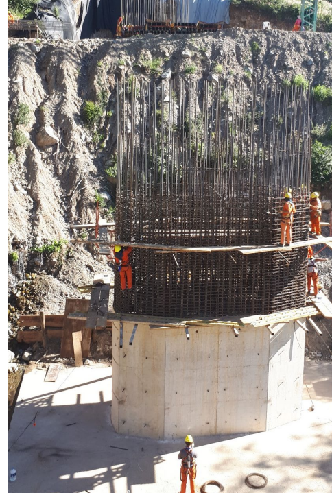
Figura 5. Sección transversal de una columnas (proyecto y construcción)
