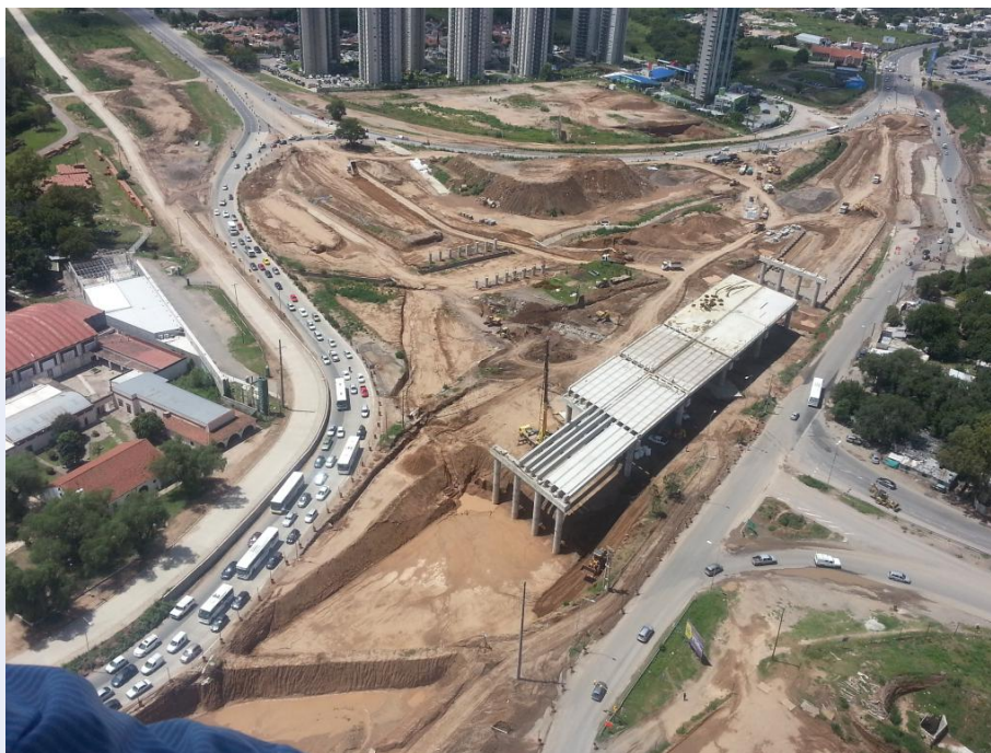
Montaje de vigas del tablero
