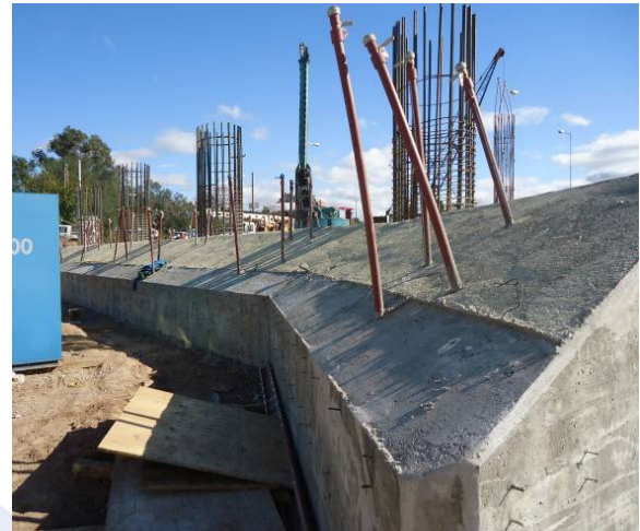
Fundaciones Estribo y Pila Viaducto Colón
