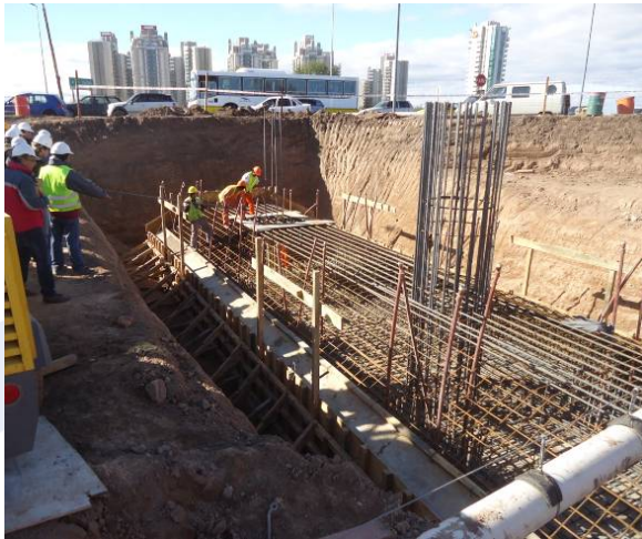
Fundaciones Estribo y Pila Viaducto Colón
