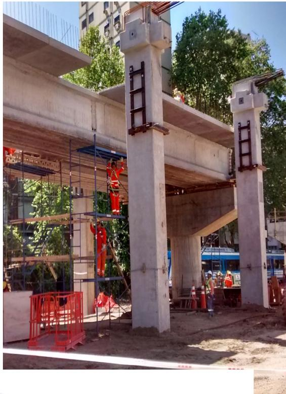
**Figura 5. Vista de columnas premoldeadas**
