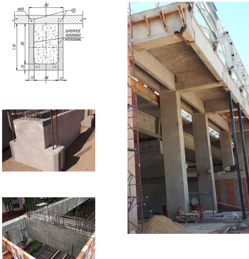
**Figura 6. Vista de dinteles, vigas longitudinales y prelosas**
