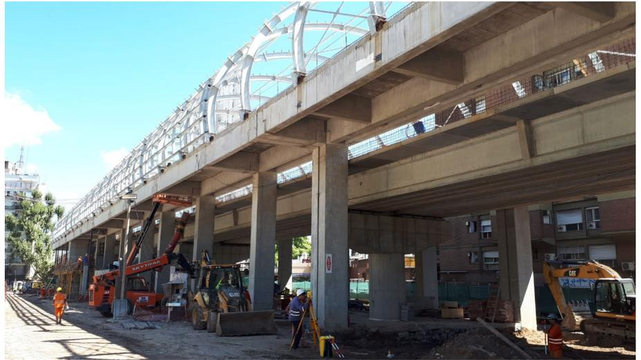
**Figura 2.** Vista particular del viaducto y andenes elevados en construcción
