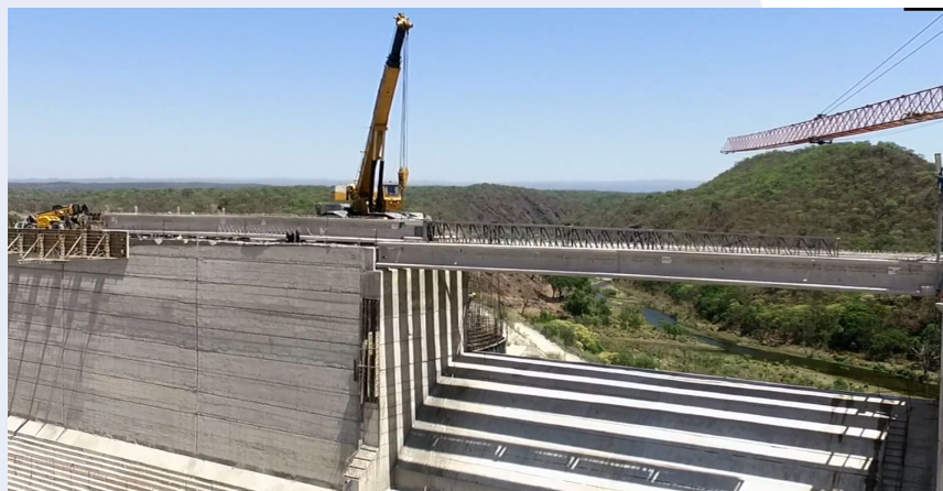
Figura 4. Imágenes aéreas del lanzamiento de primer tramo
