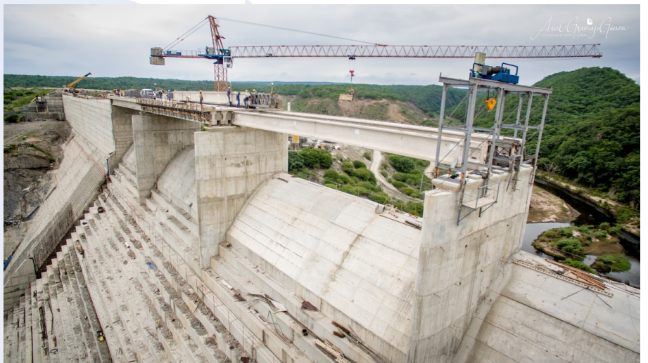
Figura 2. Fotografía aérea del lanzamiento y ejecución de tablero. Fuente (Fotógrafo Prof. Ariel Gramajo Güercci)
