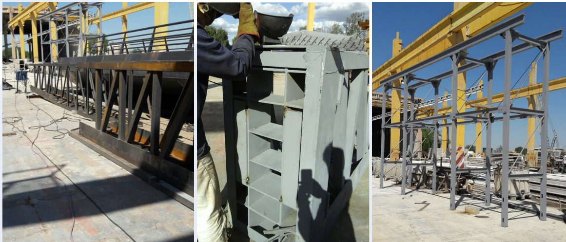
Figura 6. Elementos metálicos auxiliares para el lanzamiento
