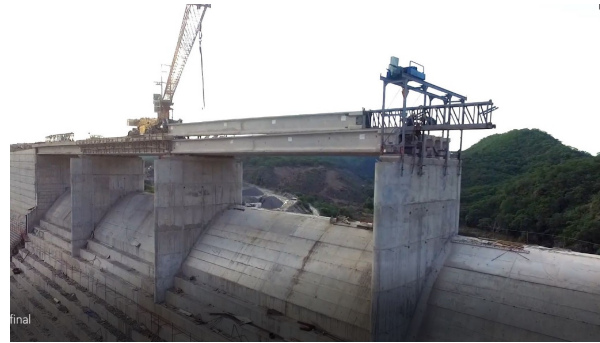
Figura 5. Secuencia de avance para ejecución de tramos
