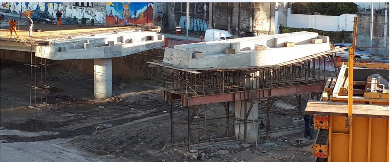
**Figura 6.** Vista de Pila Típica Monocolumna
