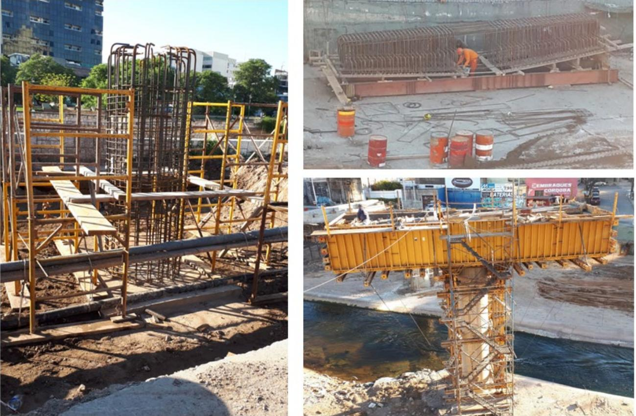
**Figura 5.** Vista de Armadura y Encofrado de Pila Típica Monocolumna
