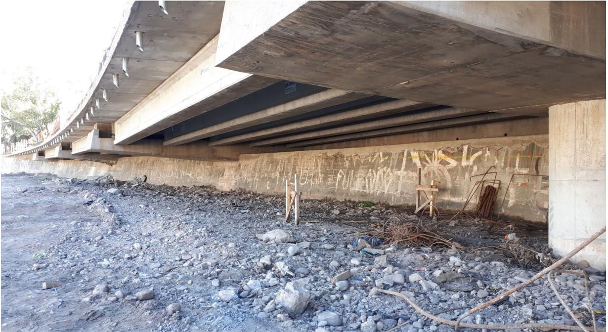
**Figura 9.** *Vista Inferior de Pilas en Ménsula*
