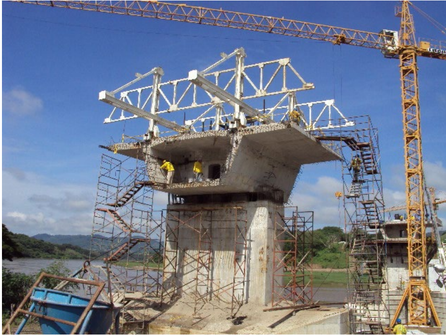
Figura 4. Instalación de los carros de encofrado y avance para la construcción de las dovelas por voladizos sucesivos
