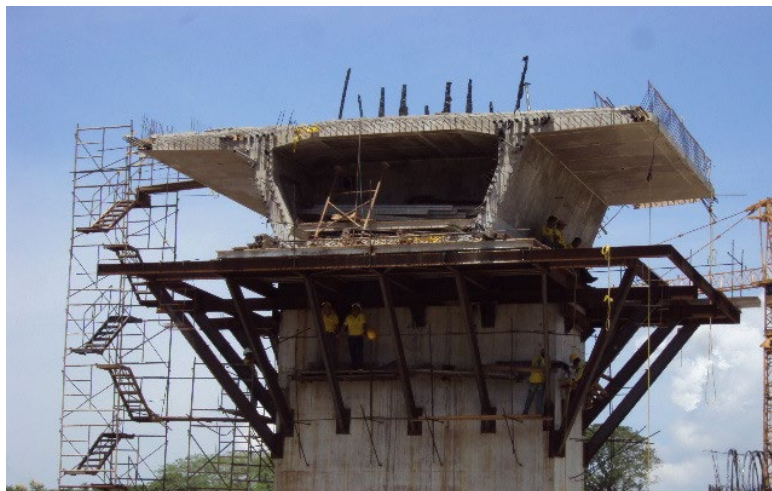
Figura 3. Sección transversal tipo “cajón” del tablero – Dovela “0”
