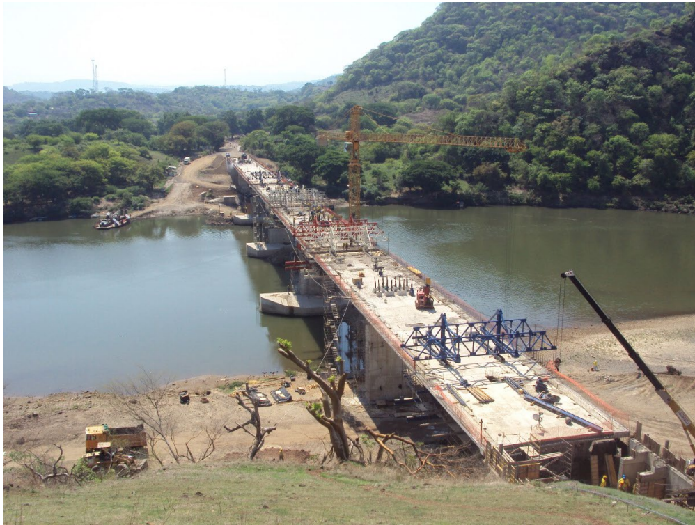
Figura 2. Vista del Puente NESJ durante su construcción
