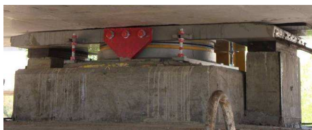
Figura 14. Apoyo tipo POT con deslizador superior
