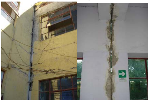
Fotografía 10. Juntas sísmicas.
