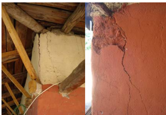
Fotografía 7. Unión techo con muros.
