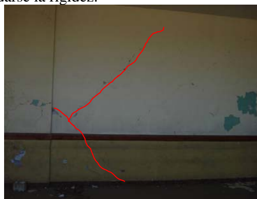
Fotografía 13. Muro de mampostería encadenada en primer piso.
