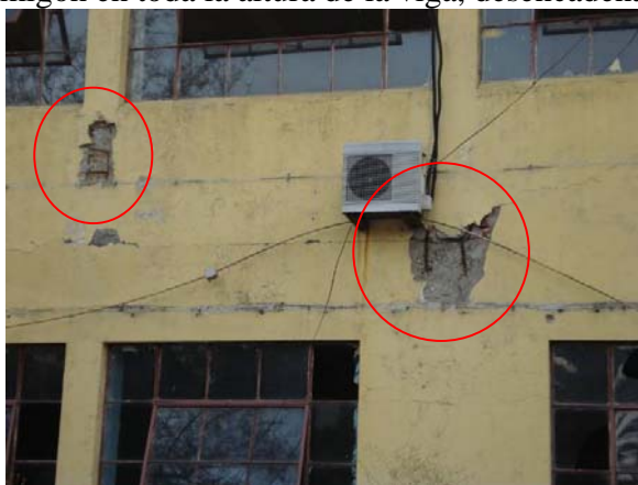
Fotografía 8. Conexión viga-columna.
