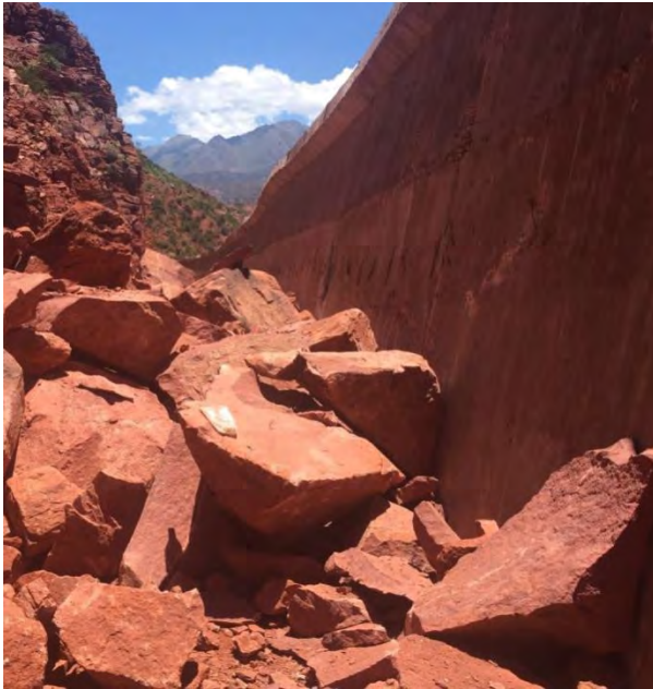
Figura 10.a. Vista de las dimensiones de los bloques caídos sobre la estructura de contención, sin relleno en el trasdós
