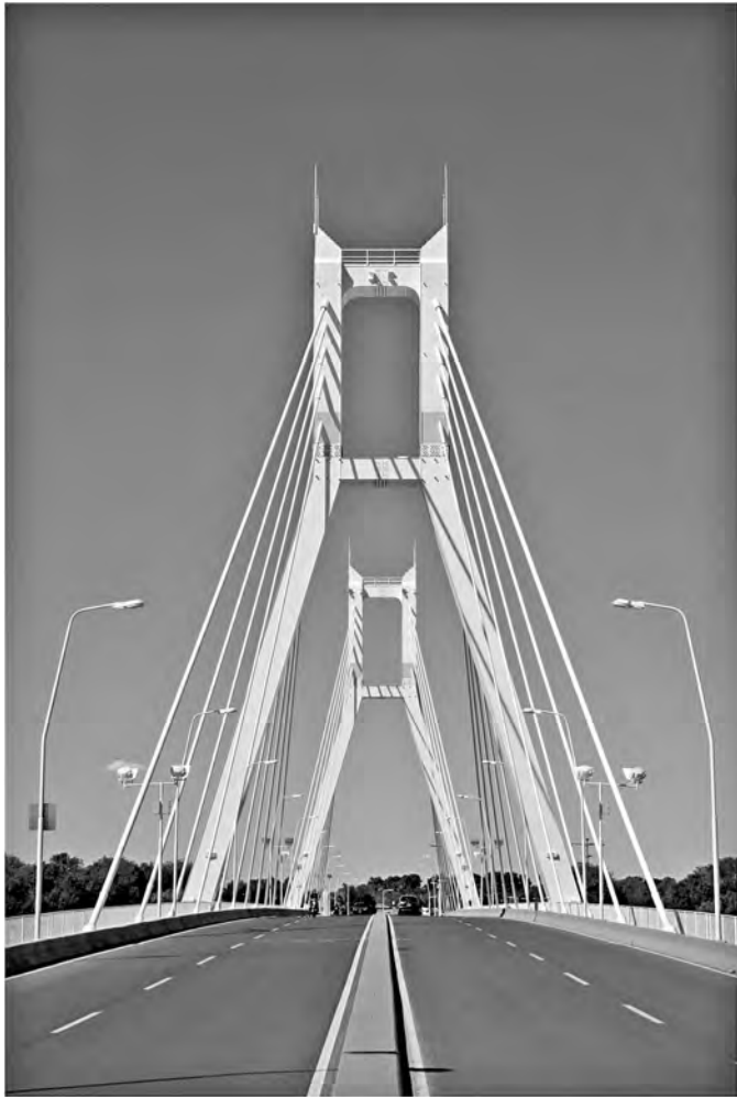
Fig. 3. View of bridge structure (image by Federico Pinto; Carlos F. Gerbaudo; and Carlos A. Prato)
