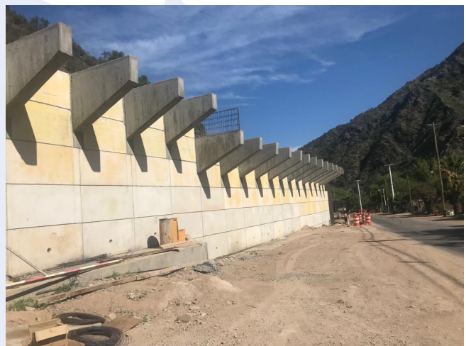
Muros Caso 2 en construcción
