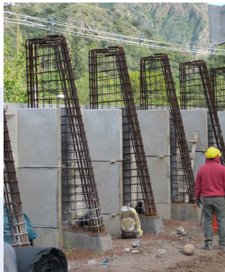
Contrafuertes de hormigón armado colado en segunda etapa
