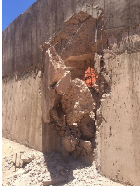
Muros Caso 3. En construcción (Izquierda). En servicio luego de impacto de roca (Derecha)
