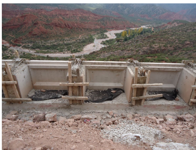
Columnas de hormigón armado colado en segunda etapa
