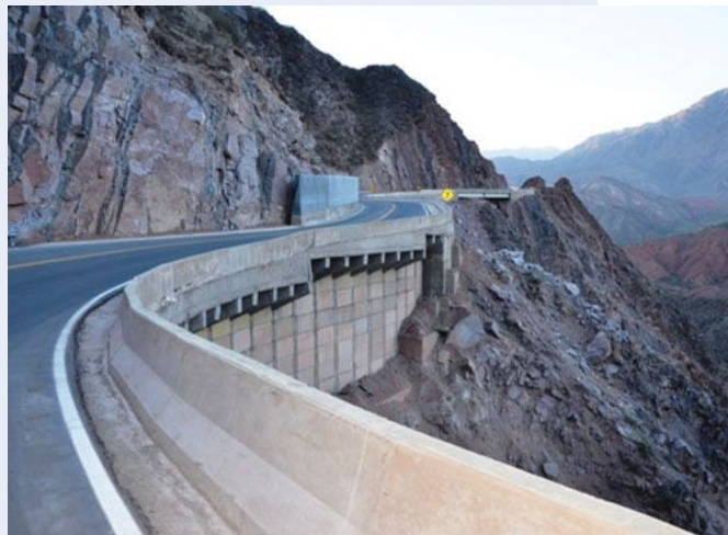
Muros Caso 2 en servicio
