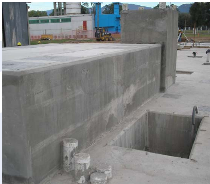
Figura 5. Base Principal – Pedestales y noyos para montaje de turbina
