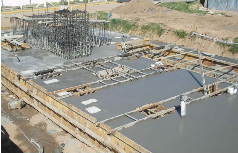
Figura 4. Hormigonado de Base Principal
