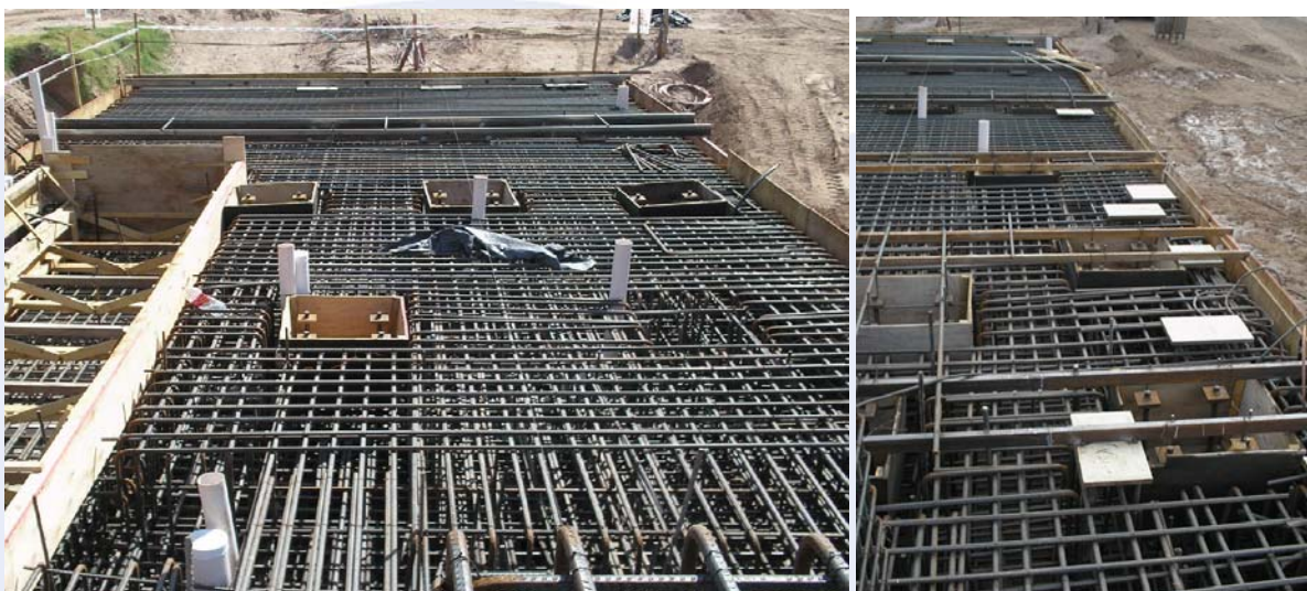
Figura 3. Encofrado de Base Principal y ubicación de insertos metálicos para montaje
