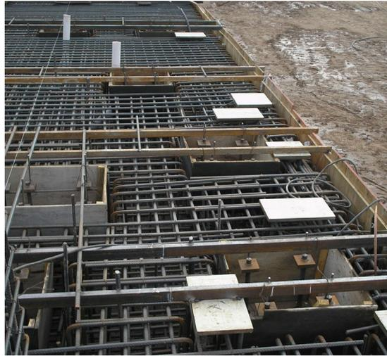
**Figura 7. Control colocación de insertos metálicos**
