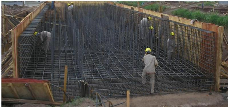
**Figura 5.** Colocación de armaduras
