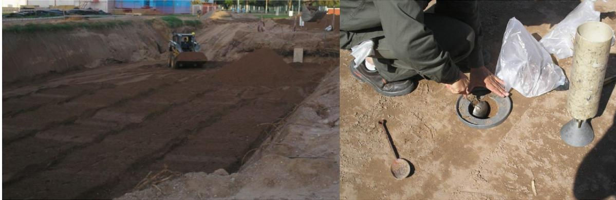
**Figura 4.** Incorporación de relleno de material granular – Control de densidad en obra
