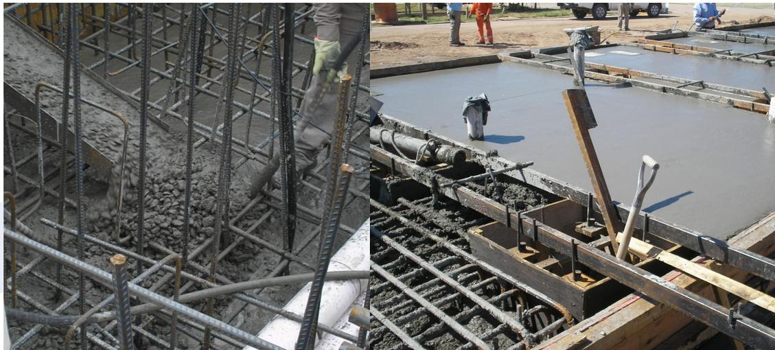
**Figura 8. Hormigonado de la Base Principal**
